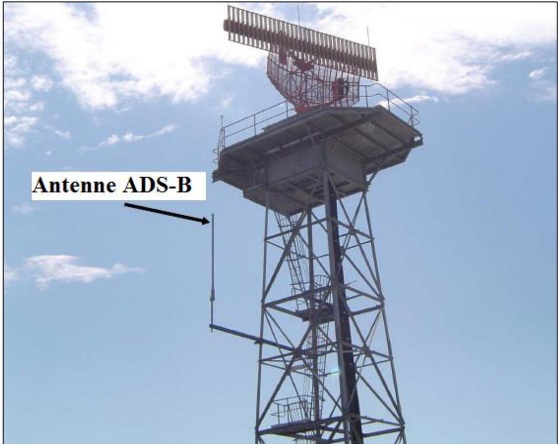
Figure II.11. Antenne d'ADS-B
