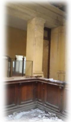
L'état des murs varie de moyen état à mauvais état. On observe de différente pathologie qui ravage l'édifice, tel que les remonté capillaire, fissuration etc....
