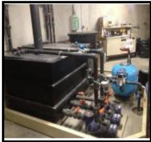
Figure 95: Filtration mécanique et biologique,
