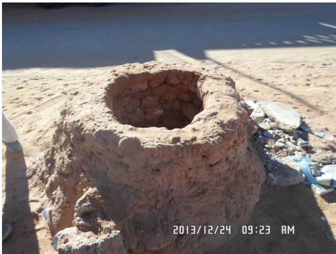
Fig. 1.5. Un des puits de la foggara de Tifena (Aouilef)
