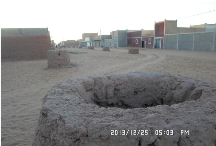
Fig. 1.8. Puits réhabilité en terre (Aoulef)
