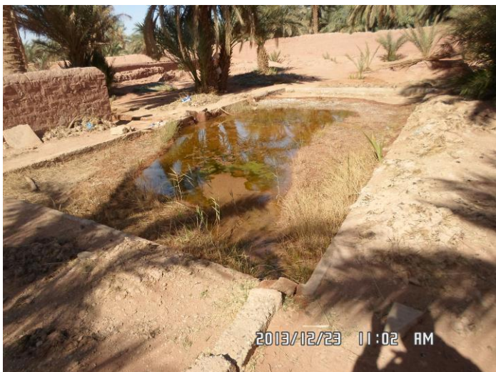
Fig. 1.15. Un des Madjens en ciment de la foggara de Bendraou (Aoulef)
