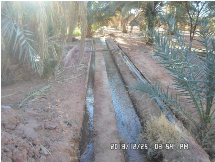
Fig. 1.13. Seguias de différentes section dans le réseau de distribution de la foggara Fguiguira d'Aoulef
