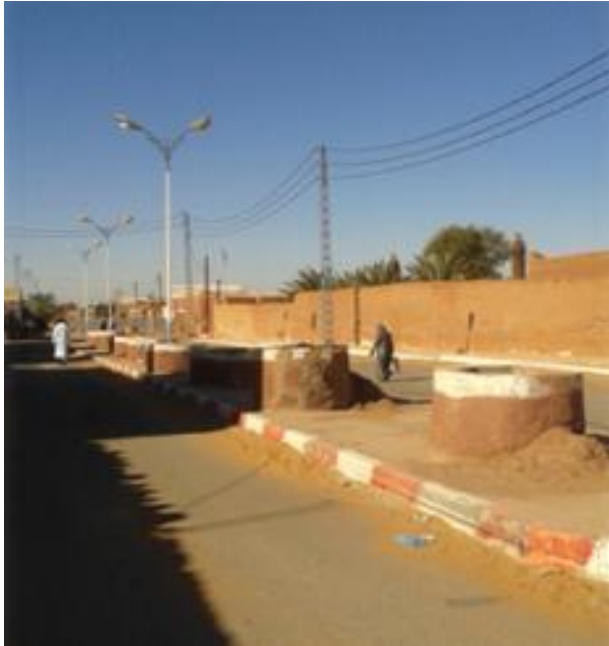
Fig.3.12. Puits d'aération de la foggara de Bendraou
