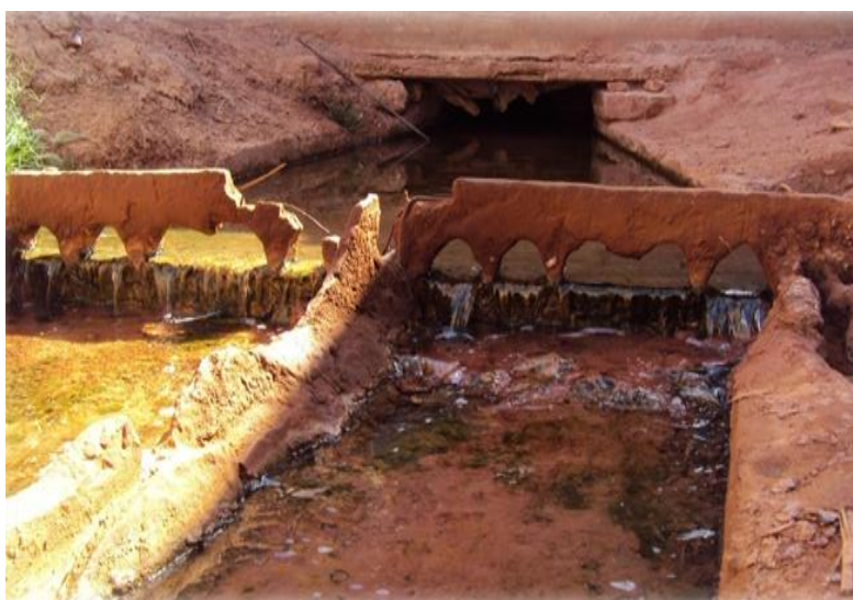
Fig. 3.11. Kasria principale de la foggara de Bendraou
