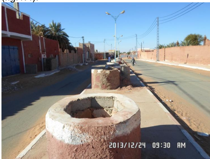
Fig. 1.4. Série de puits : synonyme de l'existence d'une galerie sous le sol (Aouilef)
