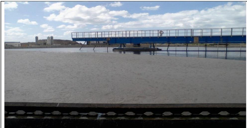
**Figure VIII.2 :** Boues flottantes au niveau de l'épaisseur
