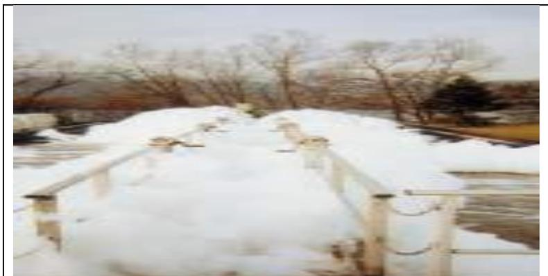
**Figure IV.6 :** Mousse blanche de démarrage en surface de bassin d'aération.
