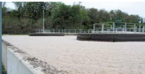
**Figure IV.5** : Mousse biologique en surface de bassin d'aération
