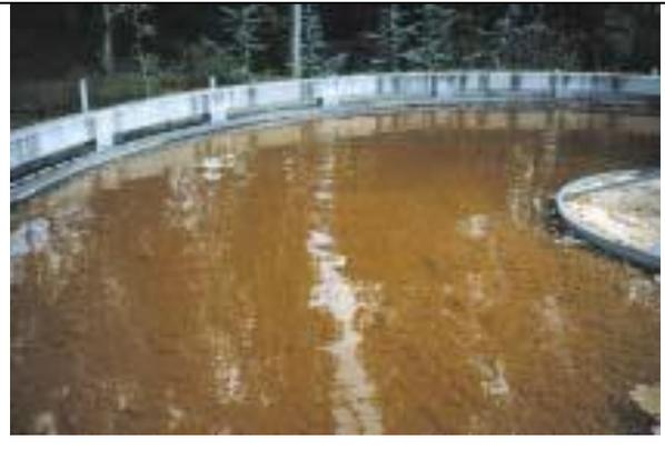
**Figure IV.13** : Voile de boue haut dans le clarificateur
