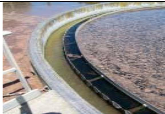
**Figure IV.8** : Flottants de dénitrification en surface du Clarificateur
