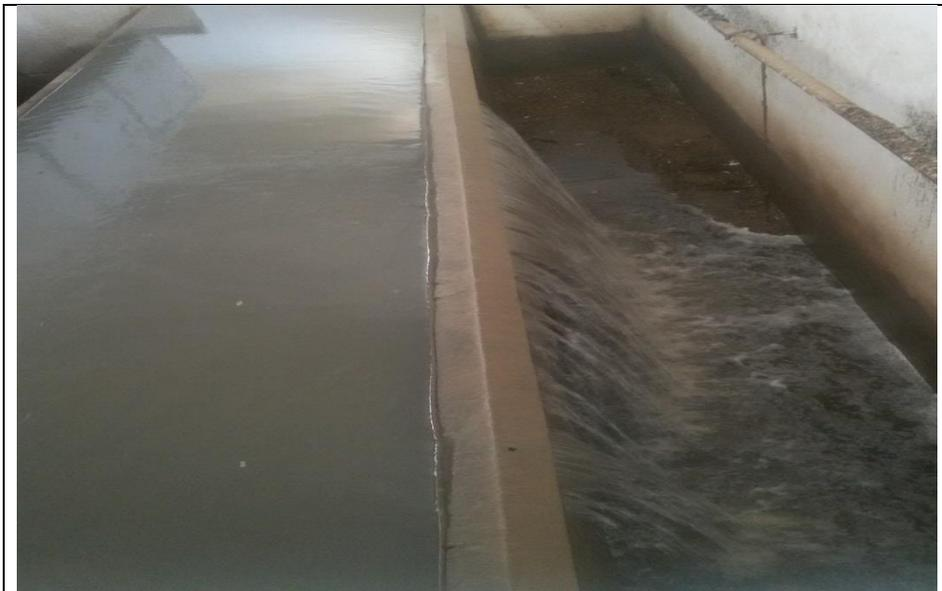
**Figure VIII.1** : Problème de diversement d'eau du au dépôt de sable dans les canaux de déversoir
