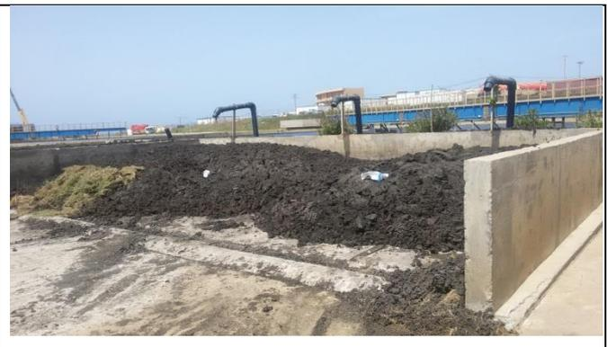
**Figure 26 : Lit de séchage des boues**
