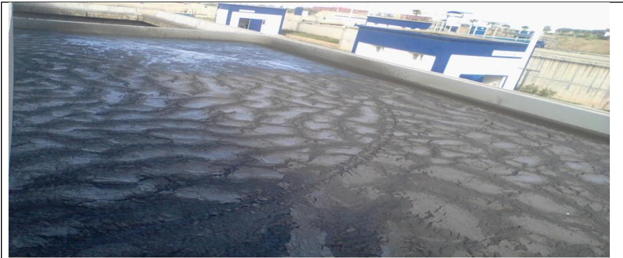
**FigureVIII.16** : Boues filamenteuse flottante au niveau de l'épaisseur
