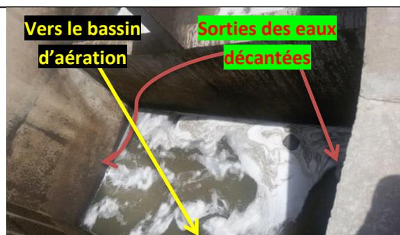
Figure VI.12 : Bassin de récupération des eaux décanter et des eaux prétraiter en excès
