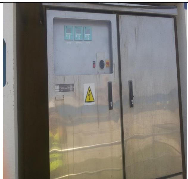
**Figure VI.21 :** armoire de mesure des pH, MES, conductivité et la T° d'eau épuré
