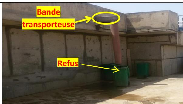
**Figure VI.5** : Extraction des refus de dégrilleurs
