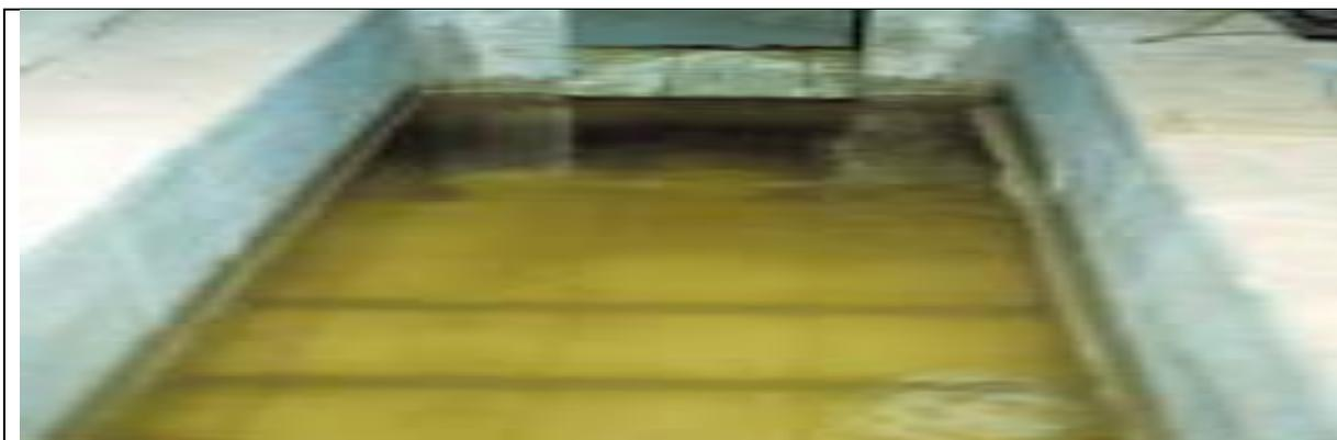
**Figure IV.15** : Sortie station – rejet « chargé » suite à des pertes de MES du clarificateur
