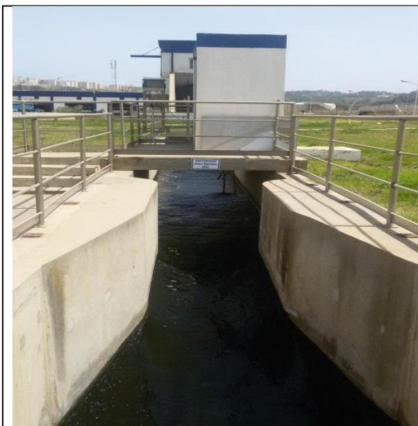
**Figure VI.20 :** canal venturi pour mesuré le débit d'eau épuré
