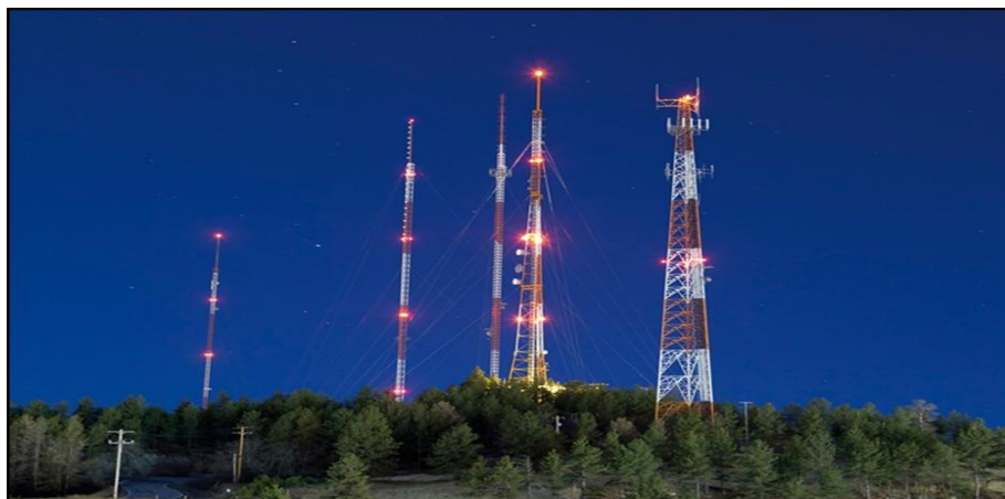
Figure 3.14: Balisage aérien des obstacles (par marquage et feux d'obstacles). [24]
