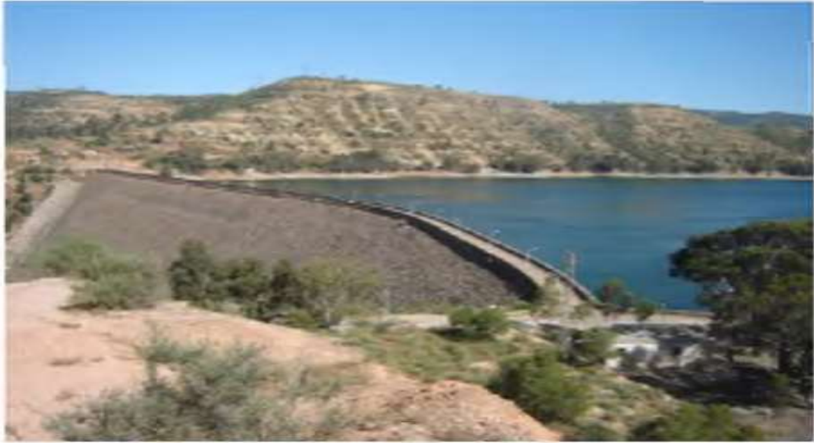
Photo 2.9 : Barrage de Bouhanifia [15].
