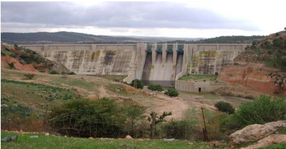
Photo 2.5: Barrage de Cheurfas [15].
