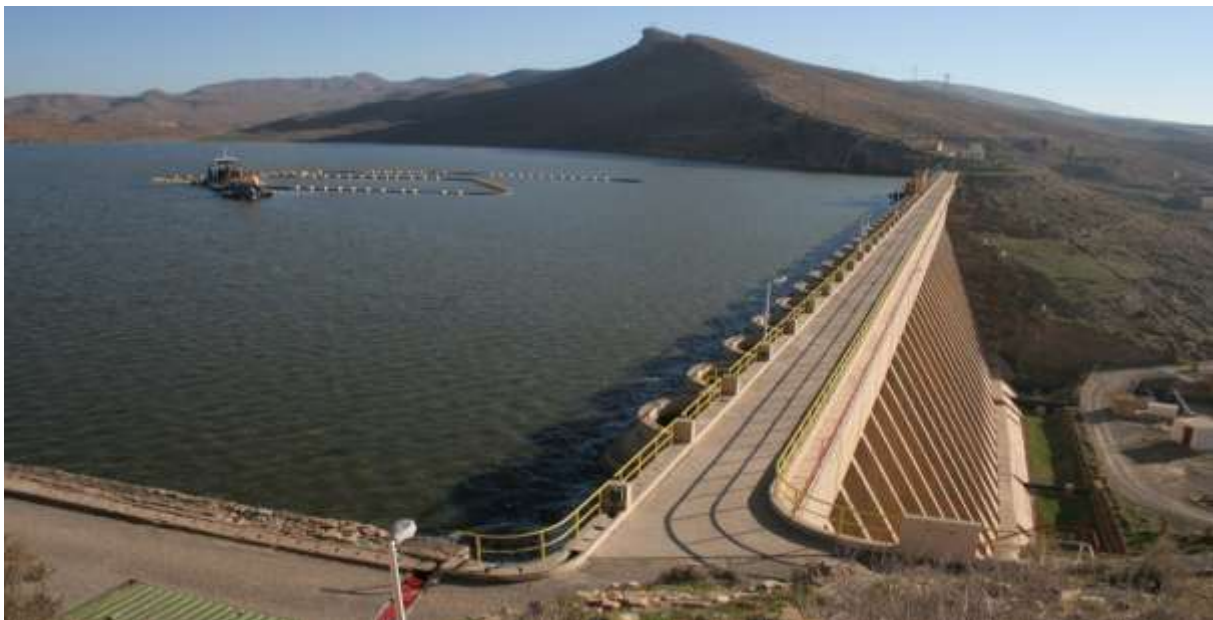
Photo 3.1 : Le dragage du barrage de K'sob [15].
