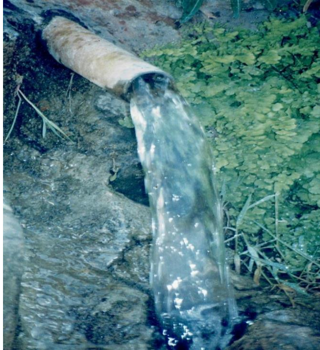
Fig. 3.15. Un exemple sur la gestion des eaux de fuites. Un système de canalisation des eaux d'infiltration destiné à l'irrigation (photo. Mai 2017)
