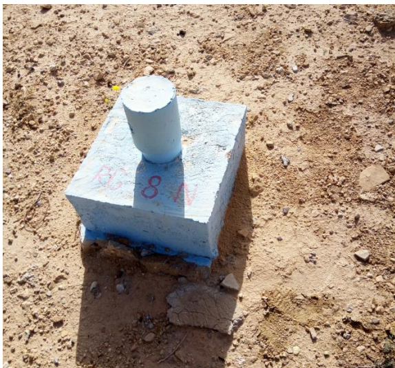
Fig. 3.10. Piézomètre fonctionnel de la rive gauche RG 8N (photo. Mai 2017)
