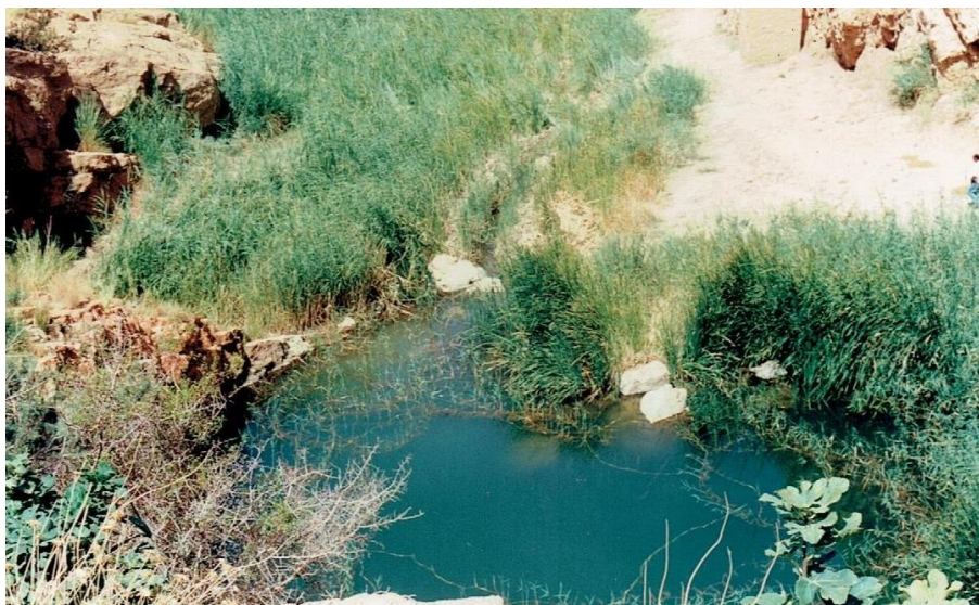
Fig. 3.22. Formation d'un lac d'eau à l'aval du barrage, suite aux infiltrations Dans la roche des deux rives (photo. 1998)
