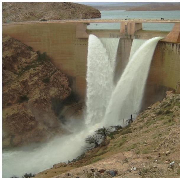
Fig. 3.17. Fonctionnement de l'évacuateur du barrage, synonyme de l'ampleur de la crue de 2008 (photo. ANBT)
