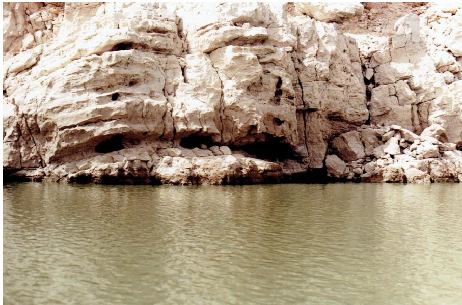
Fig. 3.19. Trous et fissures dans la rive droite (roche calcaire) de la retenue de barrage : un lieu privilégié des fuites d'eau (photo. Aout 1998)
