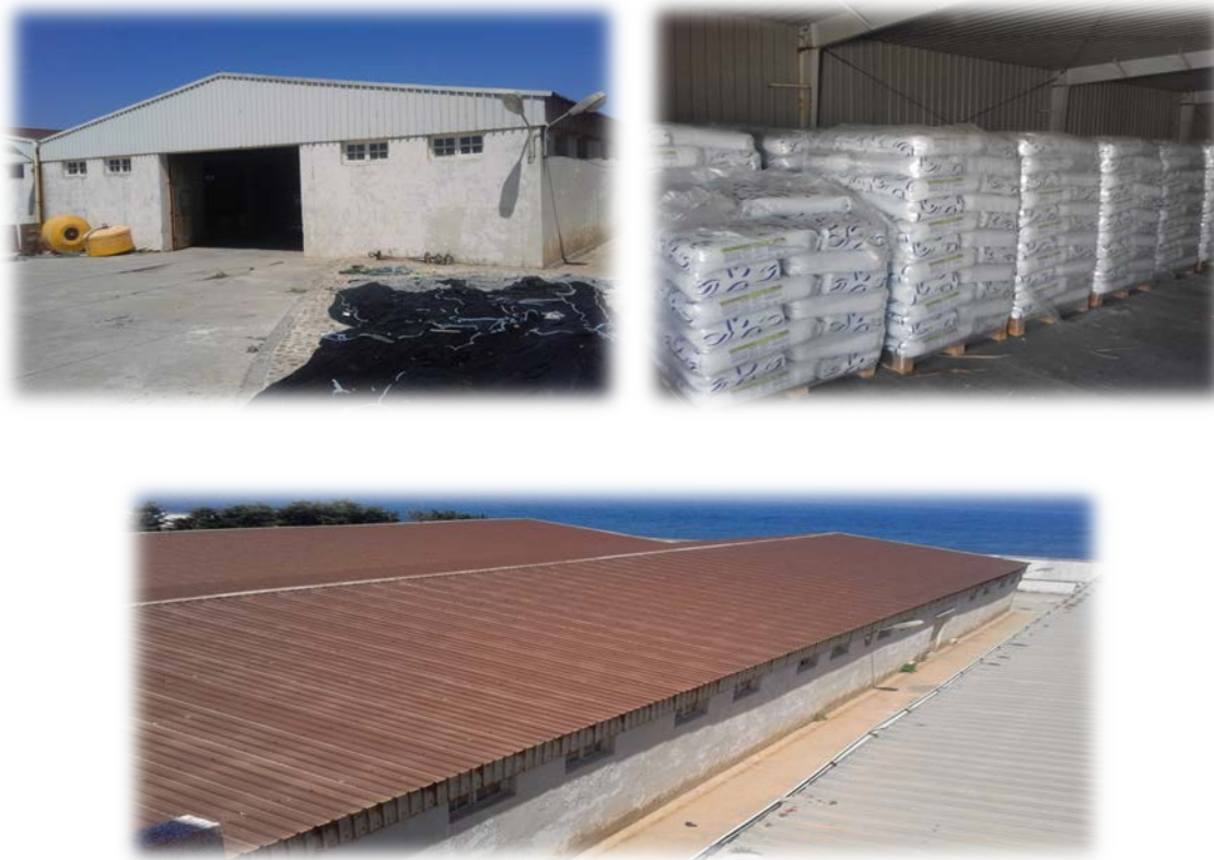
Figure 24 : Hangar de stockage d'aliment et atelier de maintenance (Photo personnelle)
