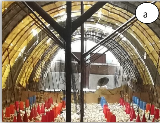
Figure 6: Système de ventilation dynamique (Pad-Cooling et grands extracteurs)
