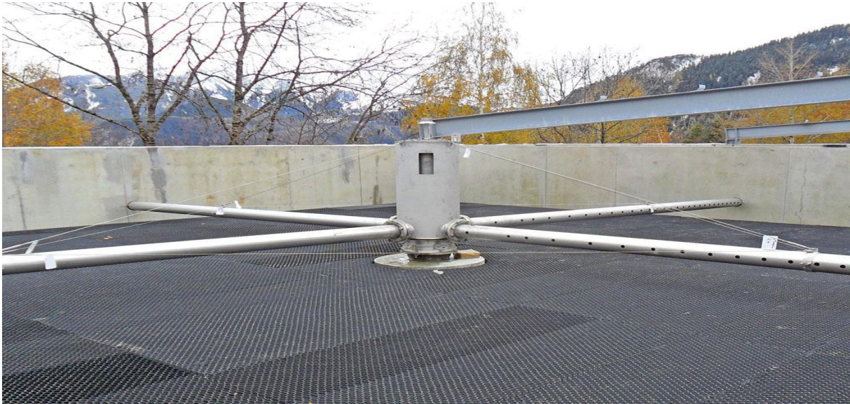
Figure II.17 : lit bactérien avec sprinkler [j].
