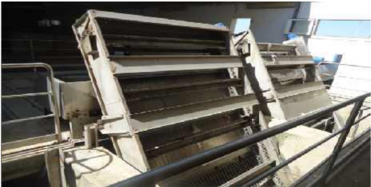
Figure II.2 : Dégrilleur mécanique [4].
