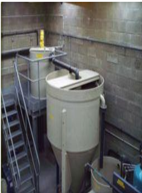
Figure II.7 : Décanteur cylindro-conique [7].
