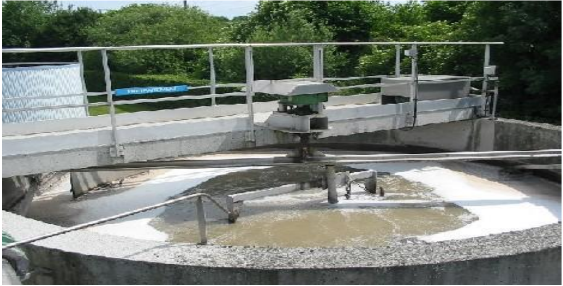
Figure II.4 : Photo d'un racleur d'huiles et graisses [a].
