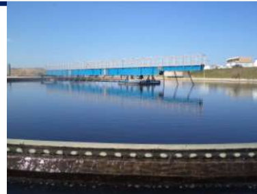
Décanteurs secondaires
