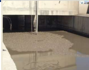
bassin de stabilisation
