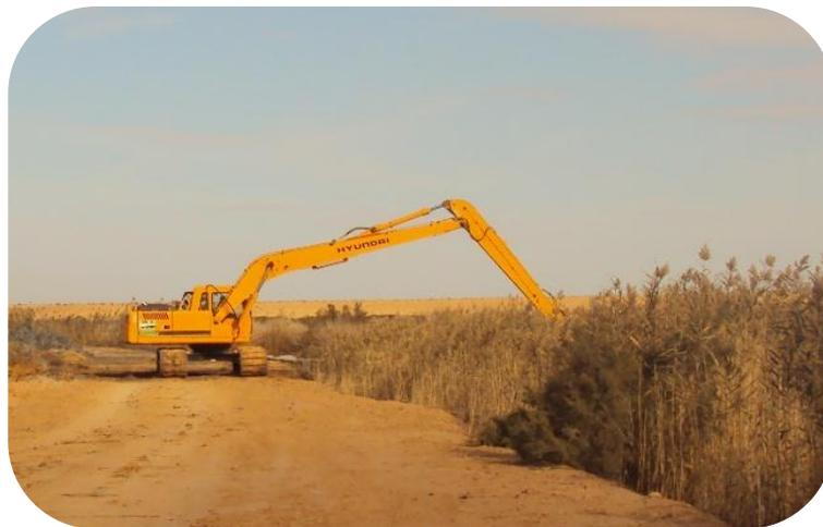
*Figure 3.35. Les travaux des curages dans la zone de Tendla.*
