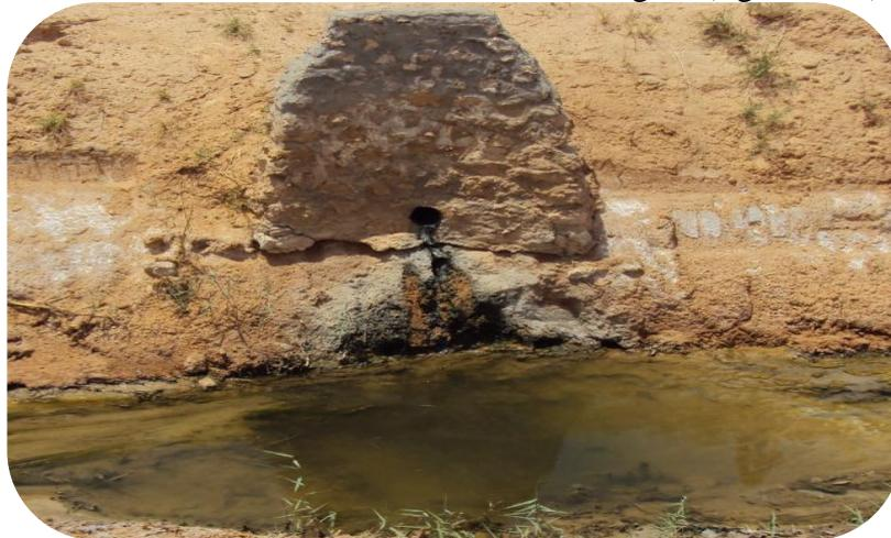
*Figure 3.27. Point de rejet au niveau un drain secondaire vers le canal*
