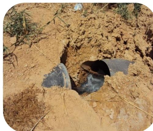
*Figure 1.19. Conduite d'assainissement non remblai*
