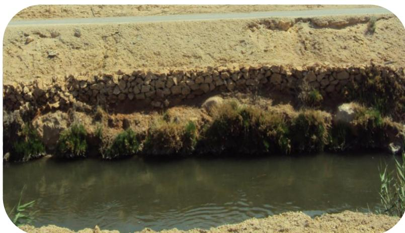
*Figure 3.28. Protection de la rive concave par les gabions*
