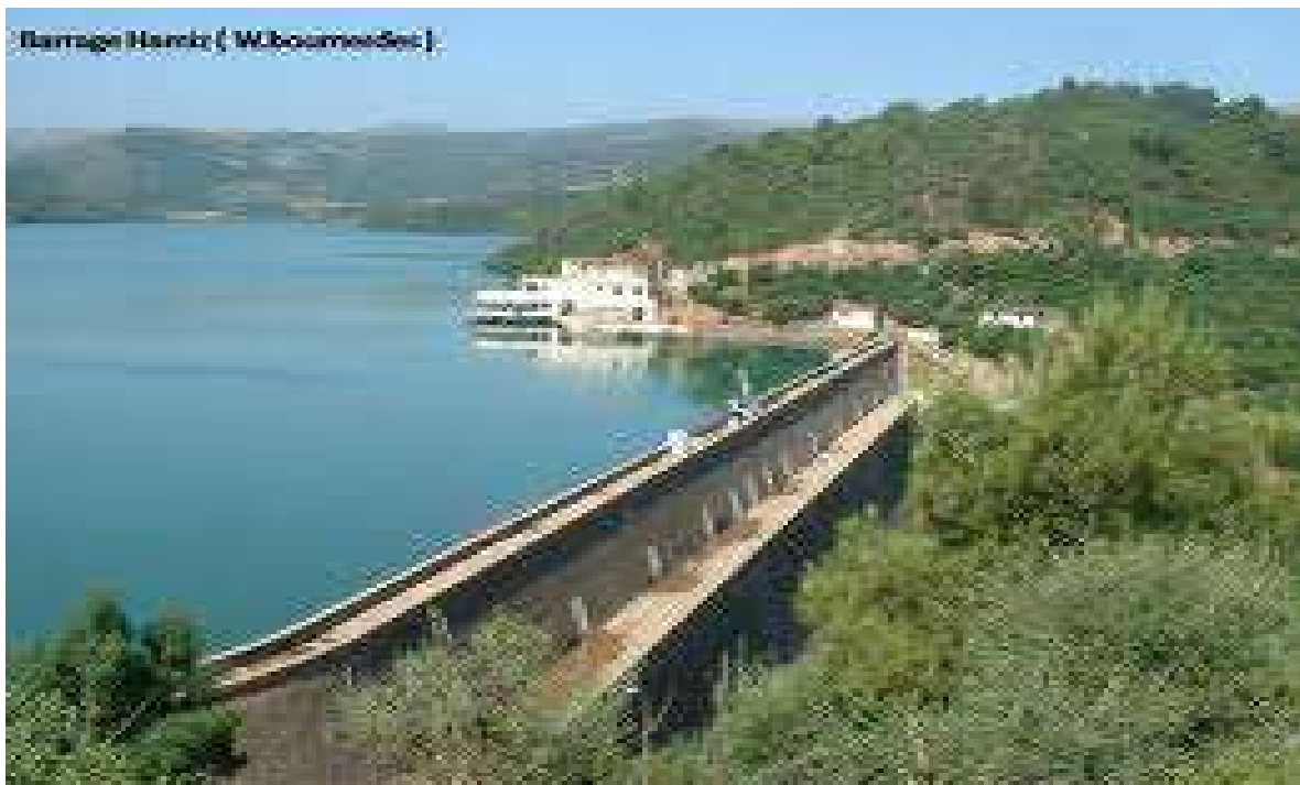
Photot-V-2: Vue de barrage du HAMIZ
