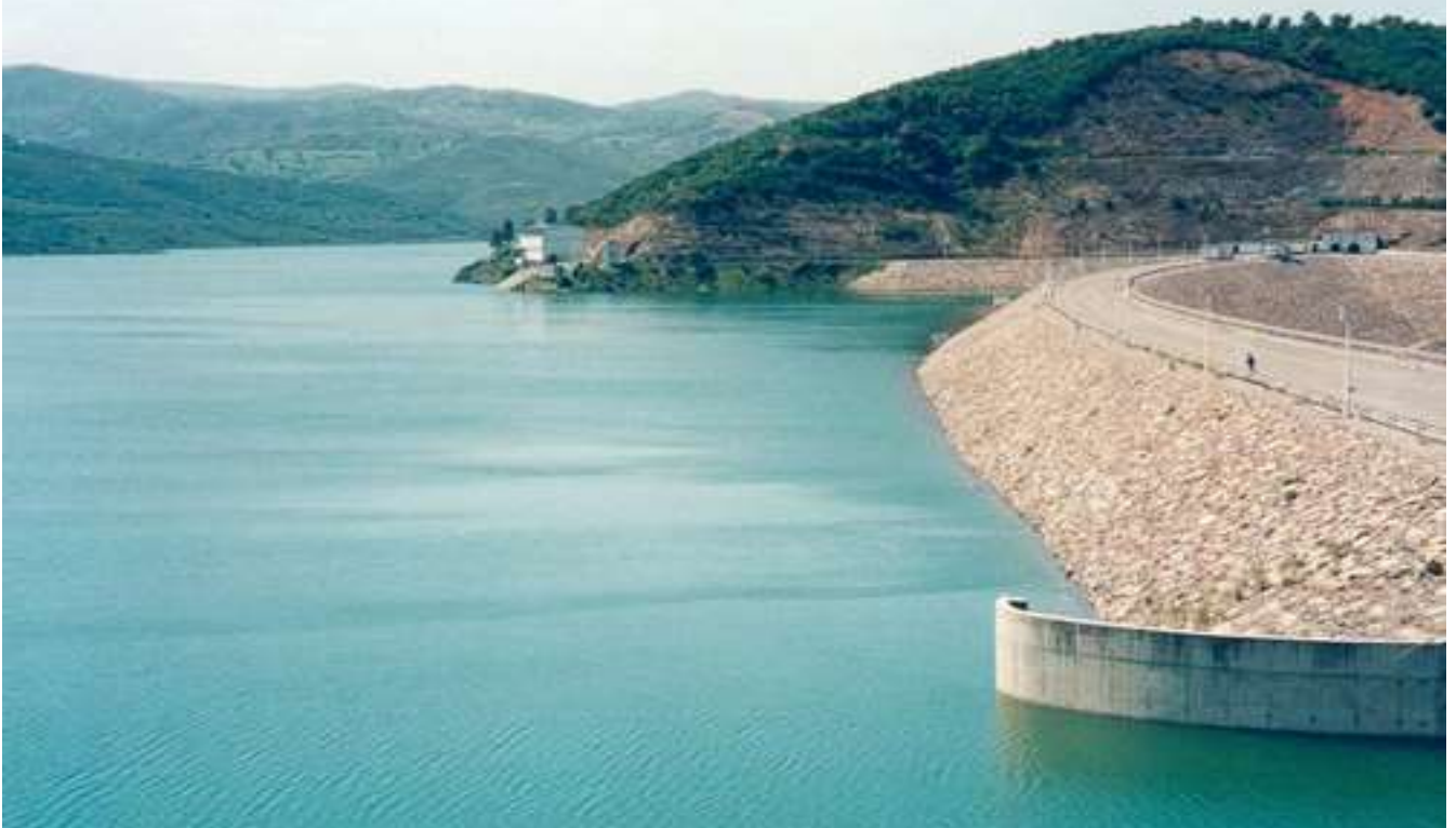
Photo- V-1:Vue du barrage de KEDDARA.
