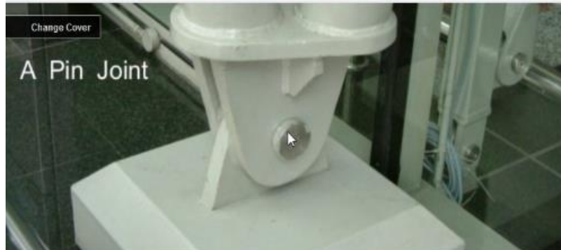
Figure VI.12 : Photo réel de l'appui (PIN JOINT).
