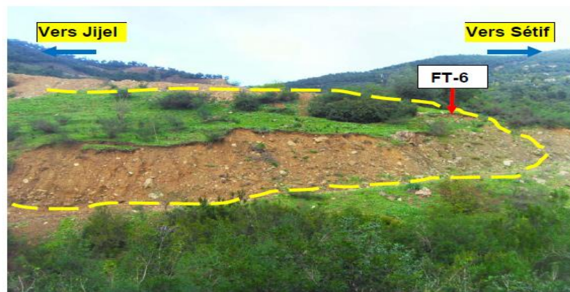
Figure II-8 : Bourrelet de glissement au portail sud de sortie.
