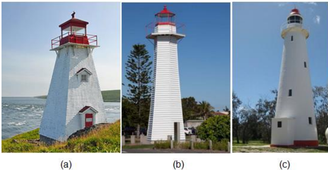
Figure 3.13 : Les différentes formes des tours en bois : (a) la tour carrée de Boar's Head (53) , (b) la tour octogonale de Cleveland-point (54) , et (c) la tour ronde de Lady Elliot Island (55) .
