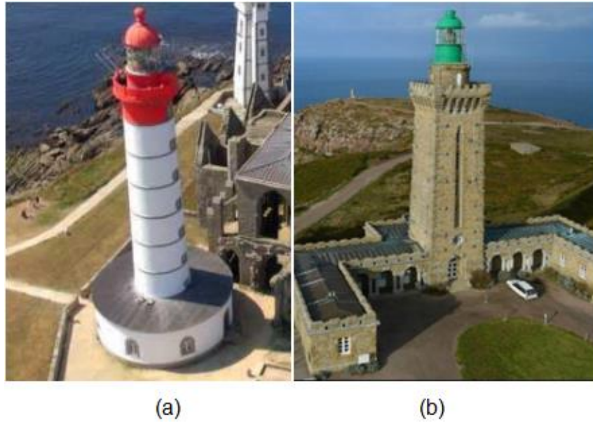
Figure 3.27 : Articulation tour-bâtiment adjacent : (a) tour au centre bâtiment (70) , (b) bâtiment accolé à la tour (71) .
