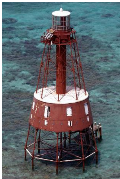
Figure 3.15 : Exemple d'un phare ajouré « le phare de Carysfort Reef, au Etats Unis » (57) .
