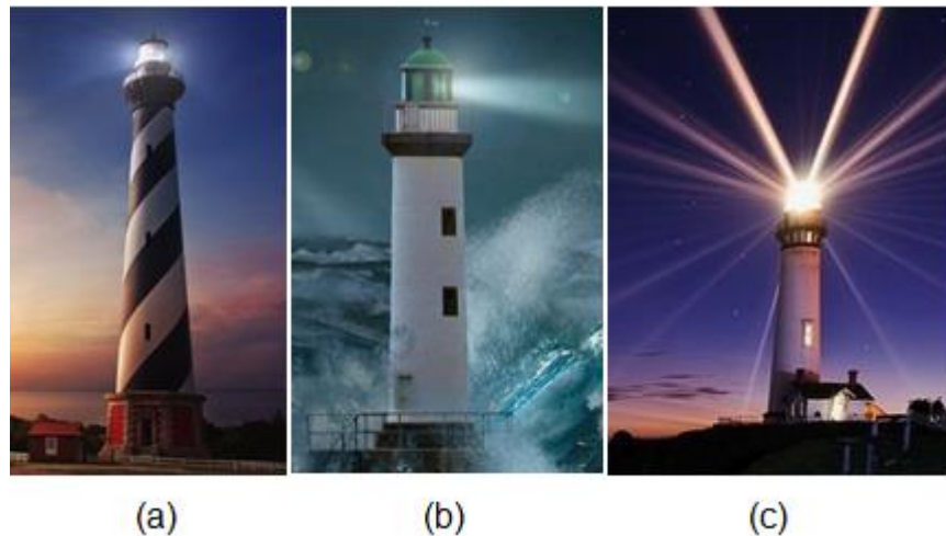
Figure 2.12 : (a) feu fixe, (b) feu tournant, (c) feu à éclats (34) .
