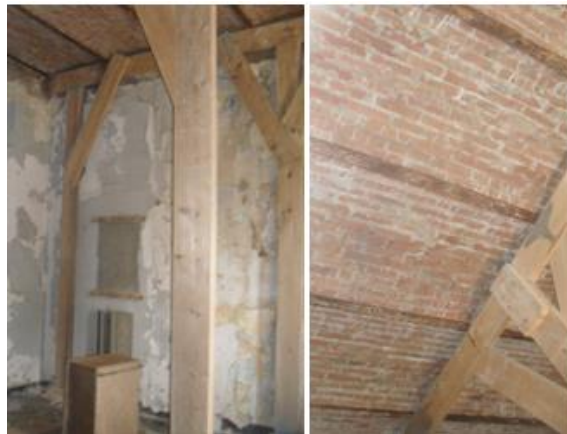
Figure 4.81 : Installation des étaielements en bois dans le phare de cap Bengut (172) .
