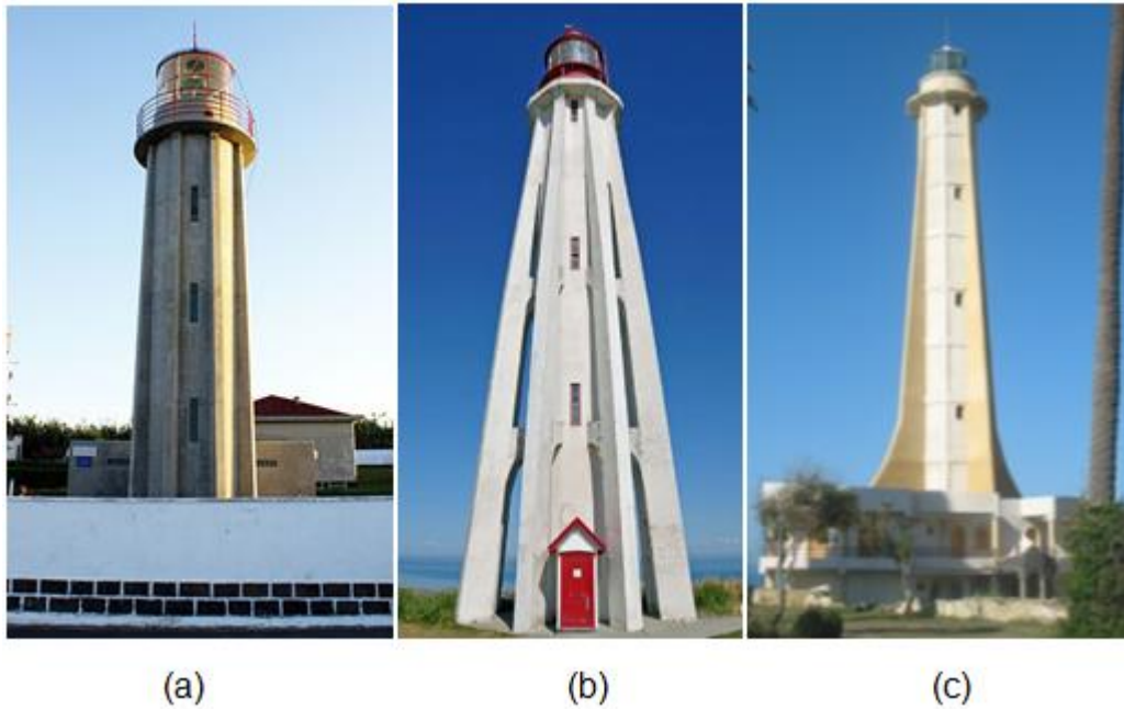
Figure 3.24 : Exemple des phares moderne en béton armé, le phare de Cintrao (66) , le phare de la Pointe au Père (67) , le nouveau phare de Dellys (68) .
