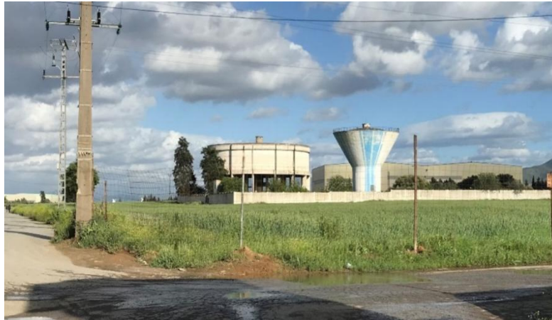
Figure 17: l'extérieur du château d'eau CH5000 m 3 et CH1000 m 3 de Brissonier
