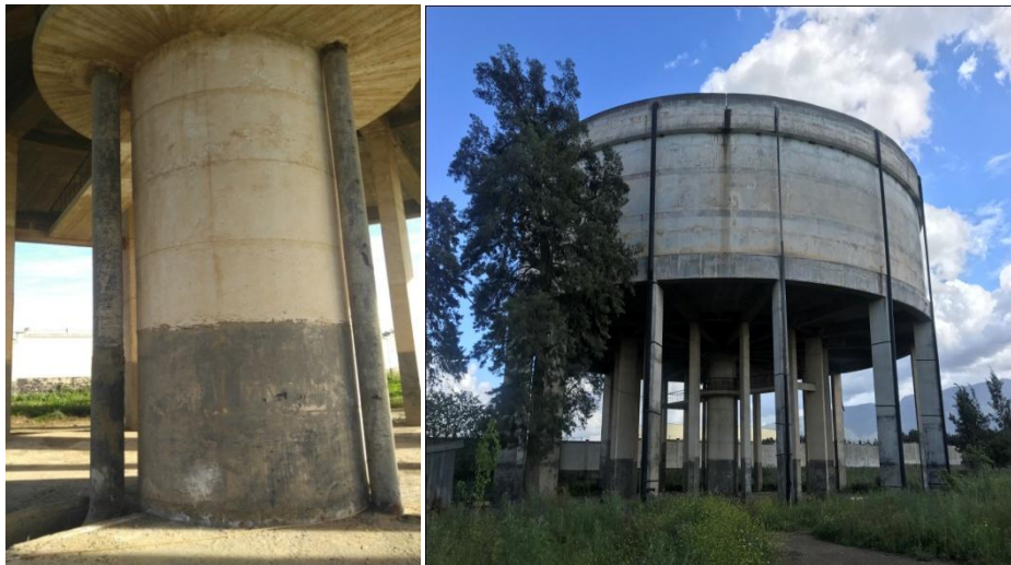
Figure 18: l'extérieur du château d'eau CH5000 m 3 de Brissonier
