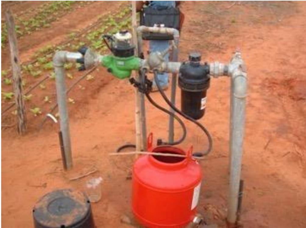
Figure 8 : Eléments de régulation, filtrage et fustigation
