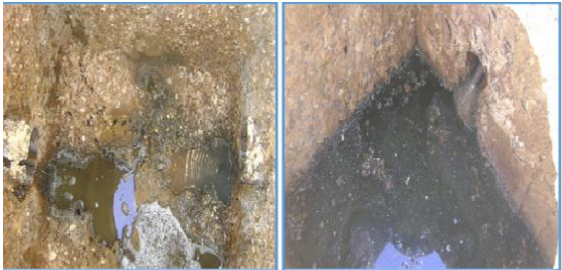
Figure7: des regards chargés du sable
