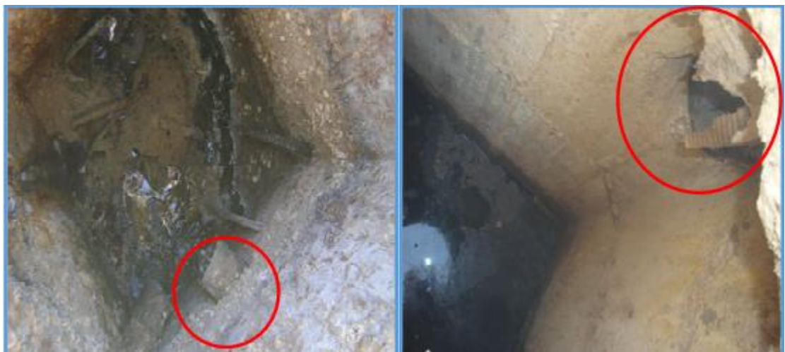
Figure3 : branchement irrégulier.
