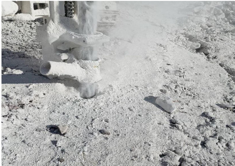
Figure 1.3 : Les travaux de foration (El Madjen).
