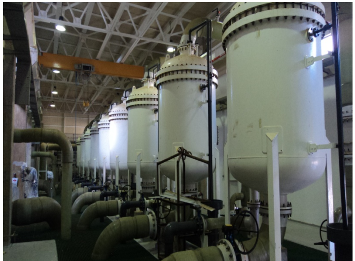
Figure V-7 : L'unité des filtres à cartouches, [ source: MESLEK.F].
