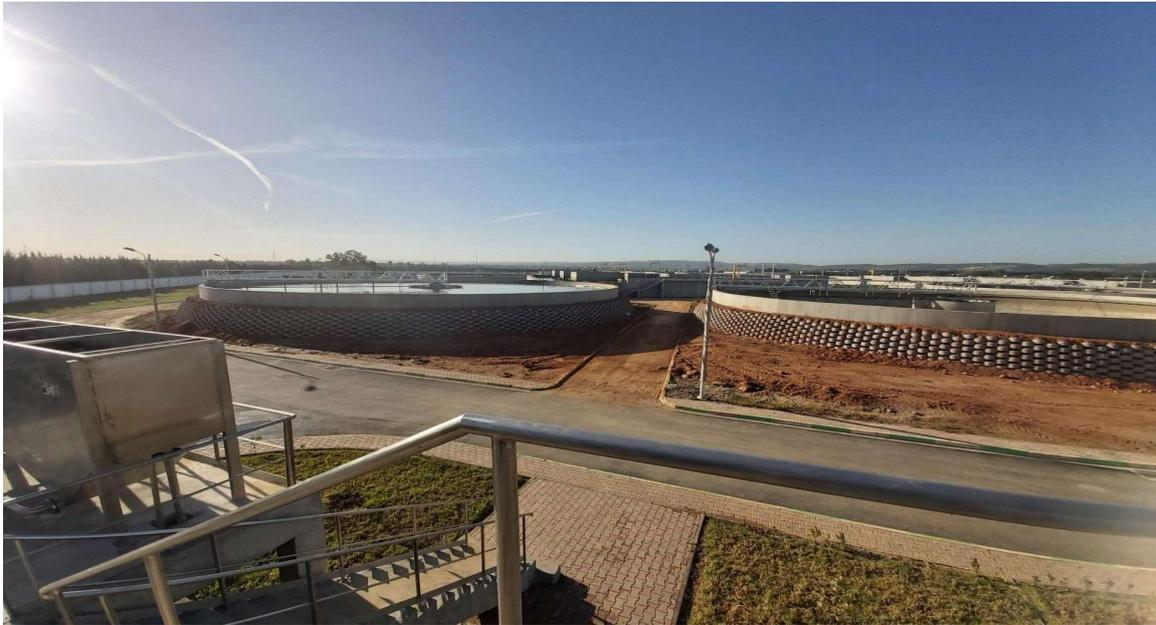
**Figure II.6 :** STEP par boue activé (STEP de Boufarik)
