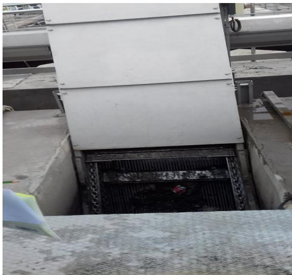
Figure II.1 : Dégrilleur automatique.
