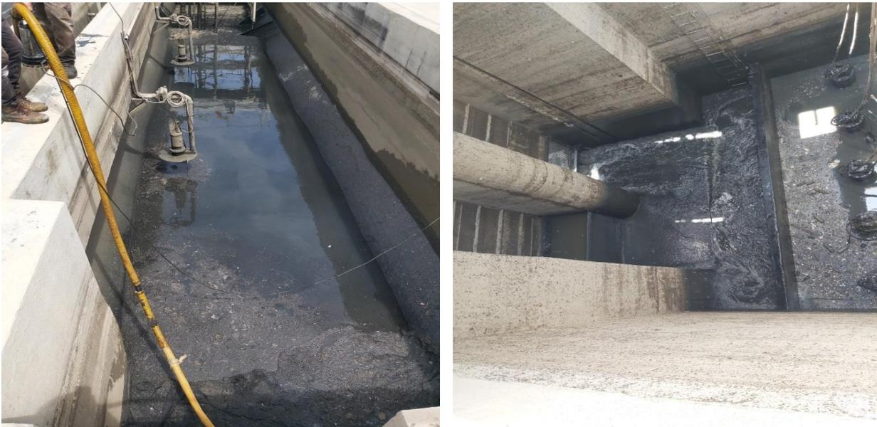
**Figure IV.4** : nettoyage du poste de relevage et déssableur/déshuileur
