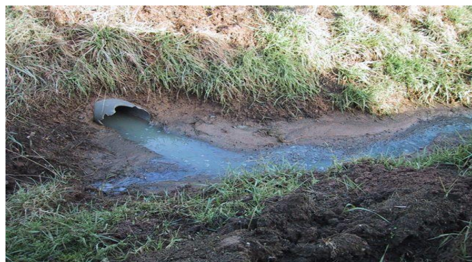
Figure I-3 : collecteurs rejettent directement dans le milieu naturel et des fosses septiques
