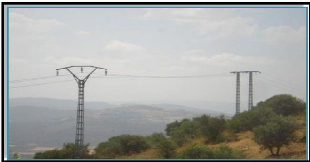
**Figure I.6** : Ligne électrique de moyenne tension [1]
