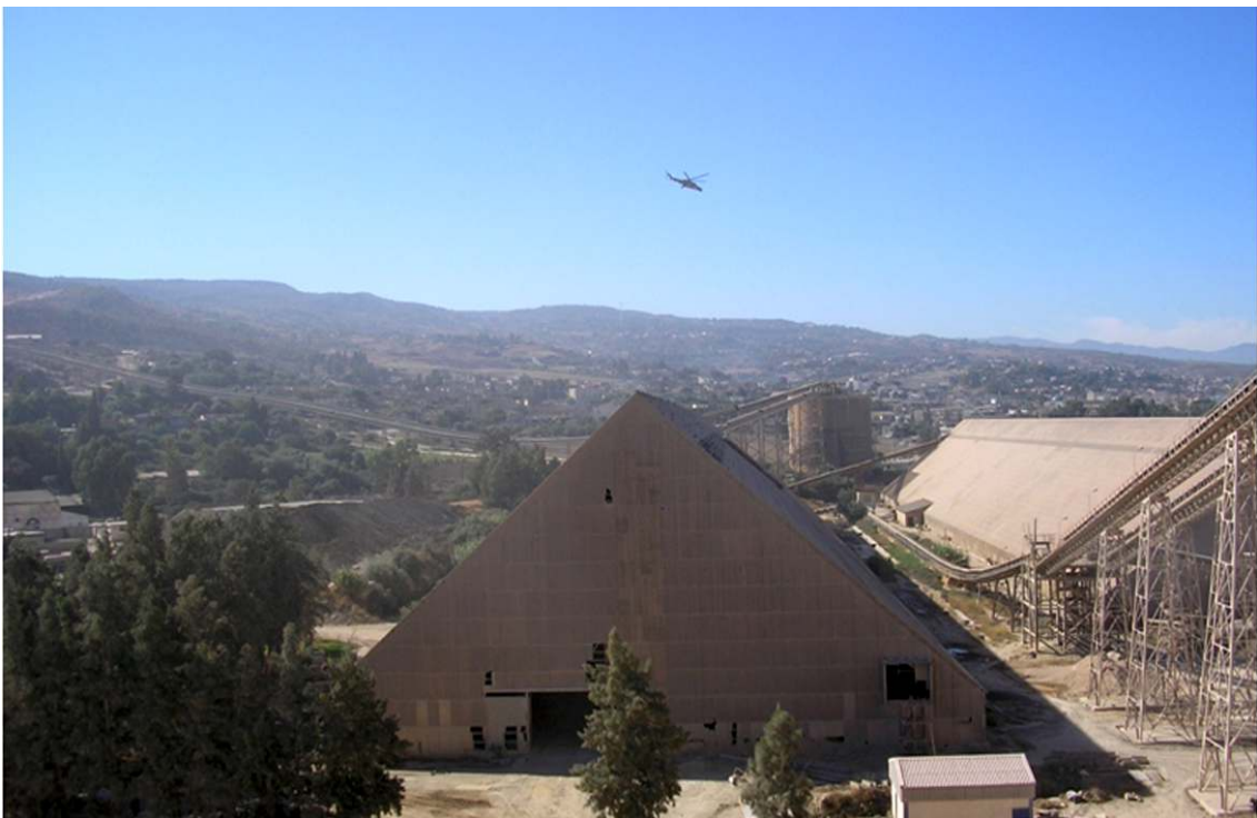
Figure 1.8 : Hall de pré-homogénéisation
