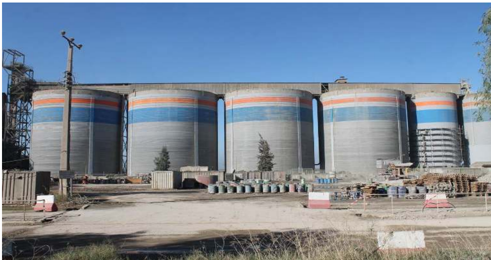
Figure 1.13 :silos de stockage du clinker, gypse et tuf.
