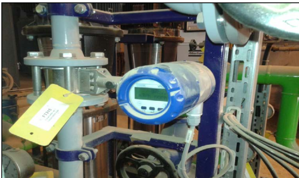
Figure II.11. Débitmètres Vortex KROHNE
