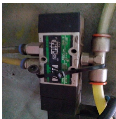
Figure 2.22. Emplacement du deuxième distributeur pneumatique bistable.
