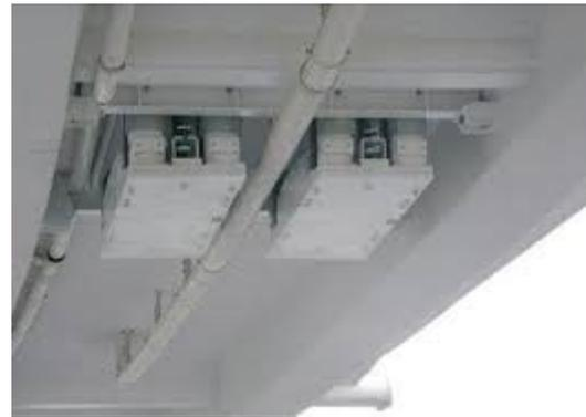
Figure 1-10 : TMDs verticaux installés sous le tablier de la passerelle du Millenium à Londres.
