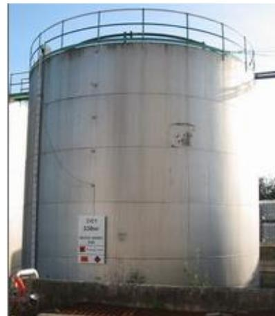
**Figure 1. 5: Des réservoirs de stockage à toit fixe typiques (horizontaux et verticaux).**
