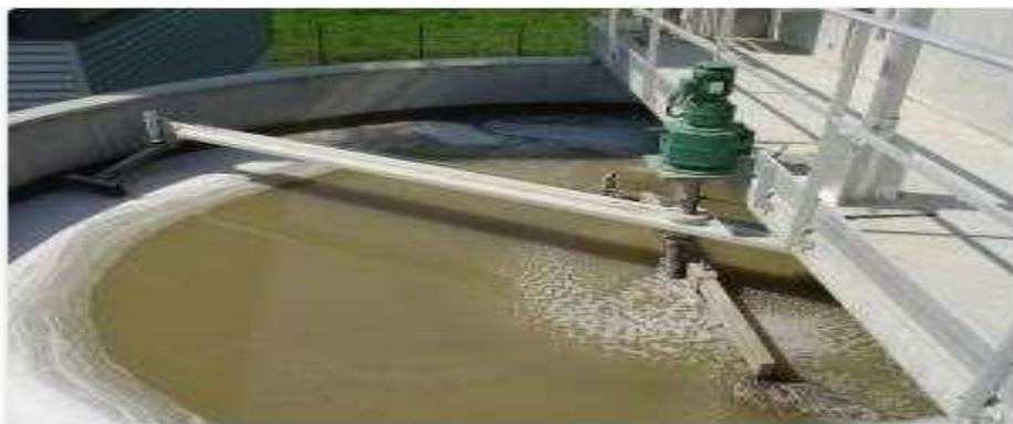
Figure 2. 2: dégraisseurs. [19]
