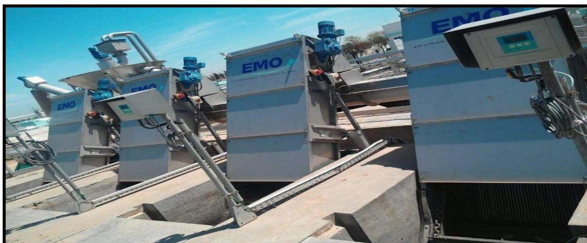
**Figure 3. 3: Dégrilleur automatique fin (Originale, 2023)**
