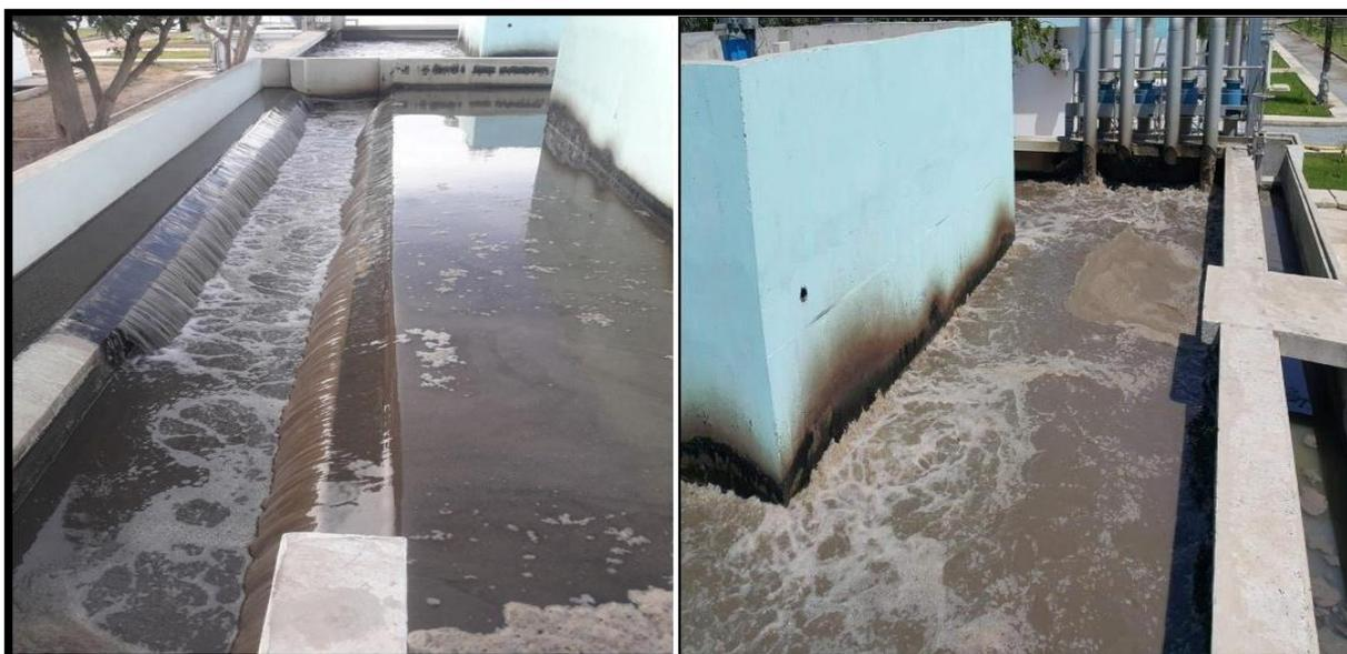
**Figure 3. 8:** Bassin d'aération de la STEP de Beni Mered .(Originale 2023)
