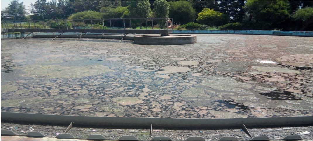
**Figure N°4: Décanteur (Photo originale).**
