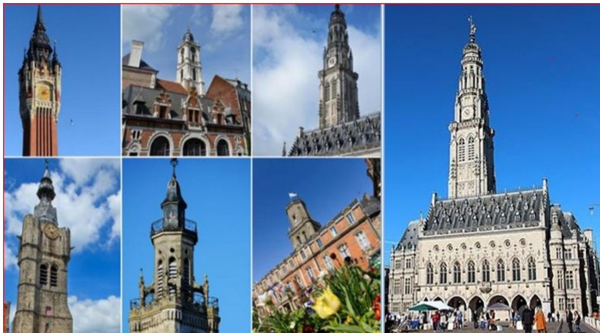
Figure 1.3 : Les différentes formes architecturales des beffrois [23].
