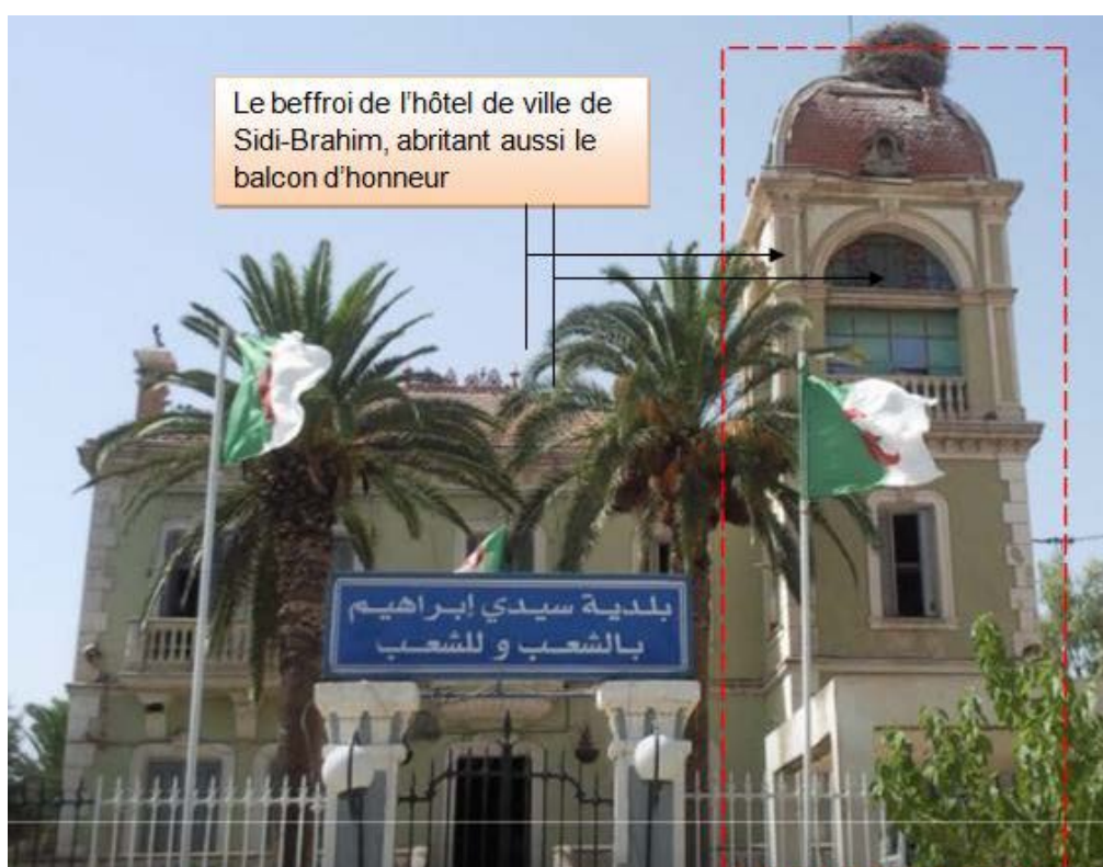
Figure 7.7 : Le beffroi de l'hôtel de ville de Sidi-Brahim.
