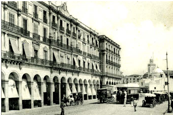
Figure 3.3 : L'ancienne Mairie d'Alger de 1883-1951
