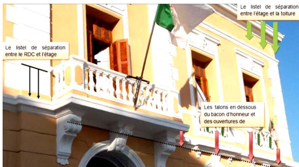
Figure 8.4 : Les différentes modénatures de la façade principale de l'hôtel de ville de Tizi-Ouzou.
