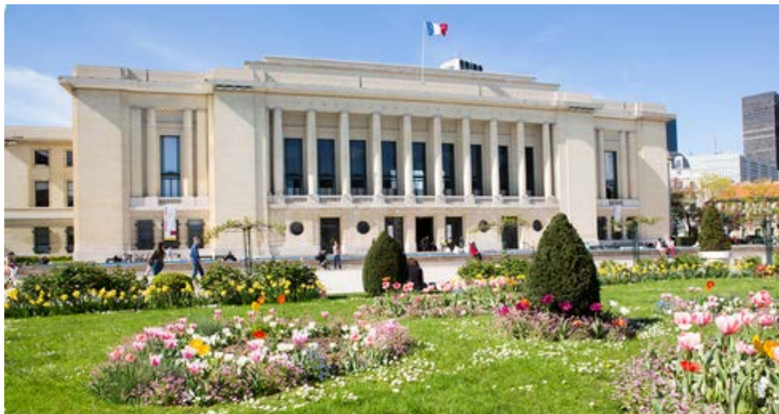
Figure 6.3 : La façade principale de l'hôtel de ville de Puteaux (France) [175].
