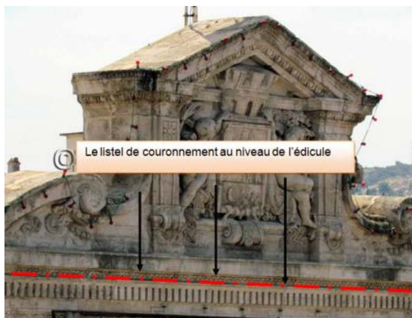
Figure 6.15 : La modénature au niveau de l'édicule.
