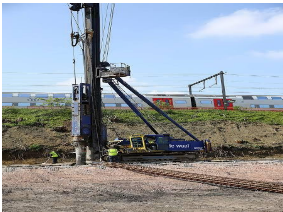
Figure 1.12 : Pieu battu moulé dans le sol.
