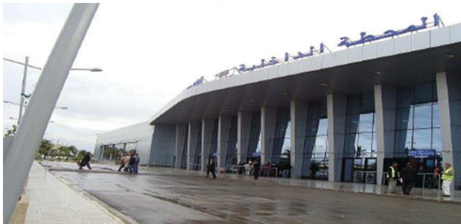
Figure II.5 : Vue d'entrée du Terminal 2 [20].
