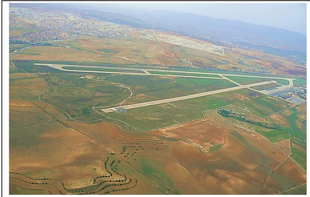
Figure2.6: Vue de l'aérodrome de Constantine [14]
