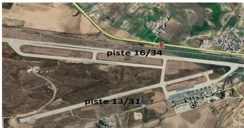
Figure2.4 : Les deux pistes de l'aérodrome de Constantine (Google earth)
