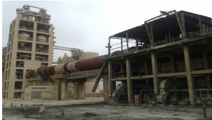
Figure 0-3. Photographie montrant la zone de cuisson du clinker
