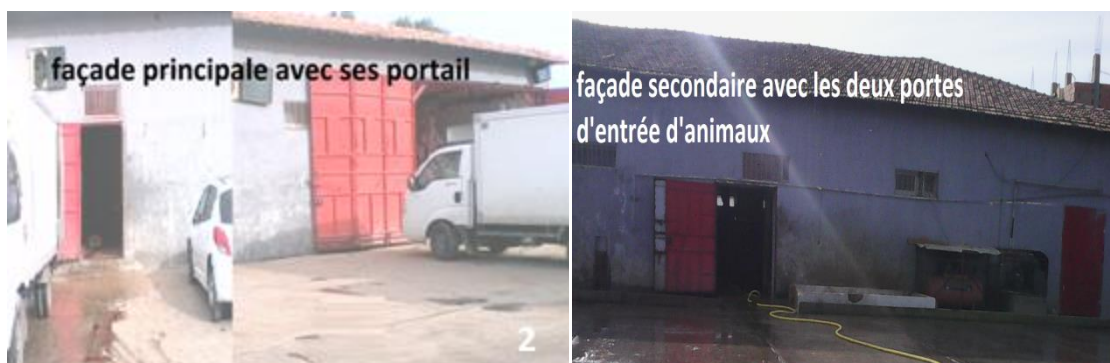
Figure 15: les deux façades de l'abattoir
