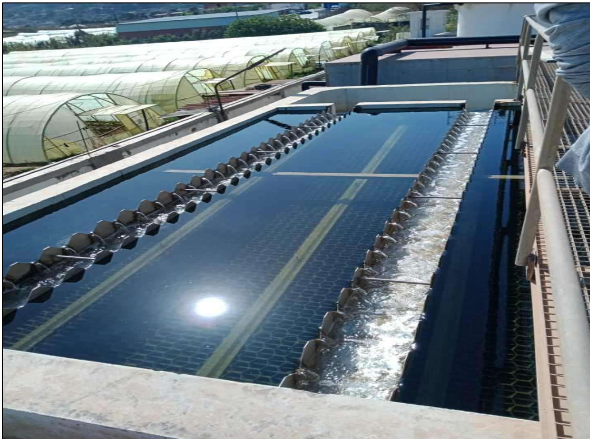
Figure 3. 6 : décanteur lamellaire.
