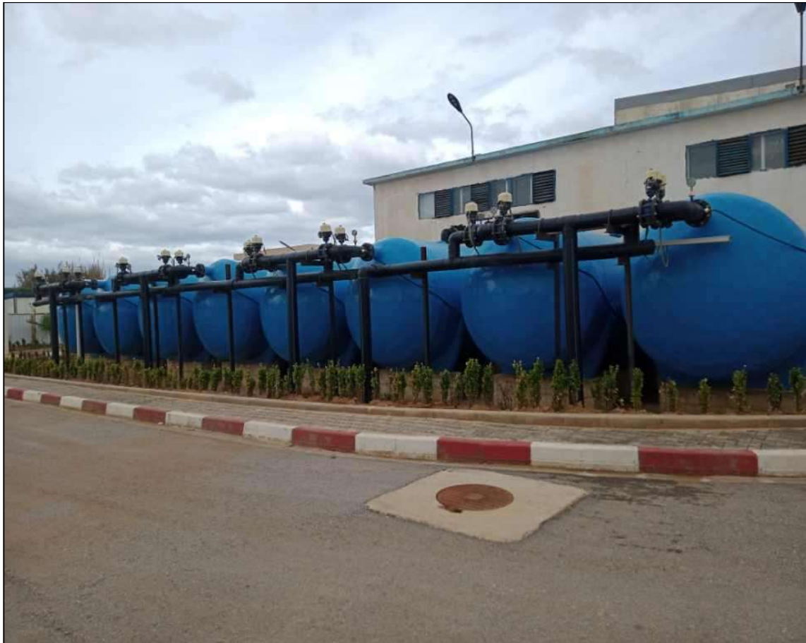
Figure 3. 7 : filtres à sable fermés.
