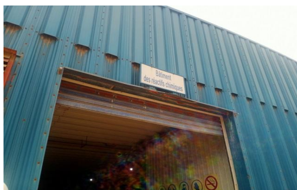
Figure IV.4: Bâtiment des produits chimique. (HASSAM, 2024)
