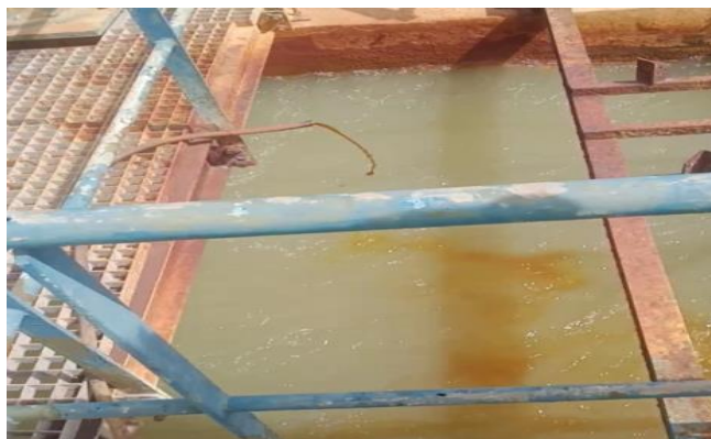
Figure IV.7: injection de chlorure ferrique. (HASSAM, 2024)
