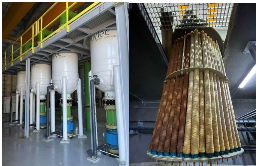
Figure 2.13. Filtres à cartouches
