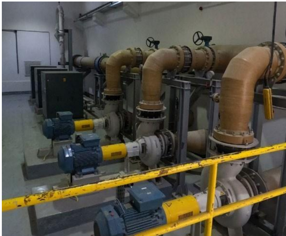
Figure 2.14. Lavage à contre-courant / Rejet
