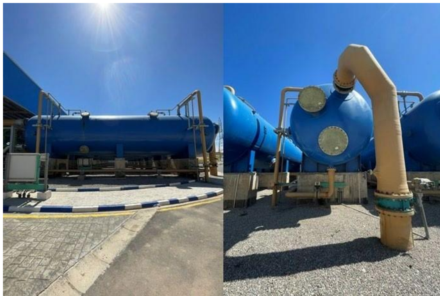
Figure 2.12. Filtre à sable
