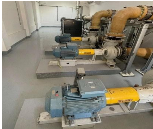
Figure 2.25. Pompes de lavage à contre-courant
