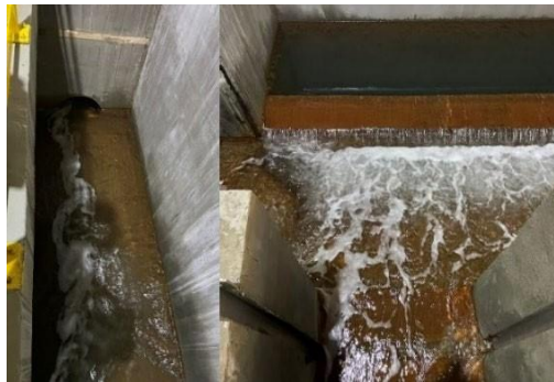
Figure 2.9. Passage d'eau vers la bêche d'eau clarifiée
