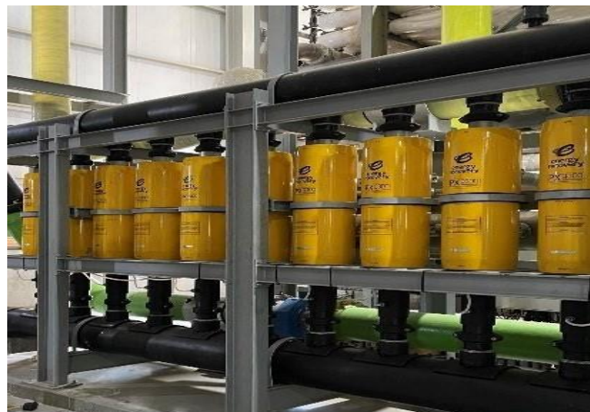
Figure 2.33. Système d'échangeur de pression
