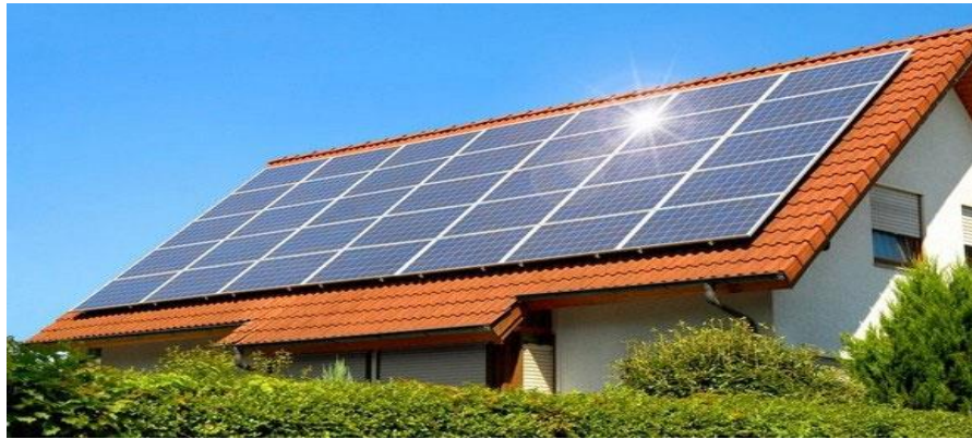
Figure (I.6) : Installation de Panneaux Solaires sur un Toit Résidentiel [5]
