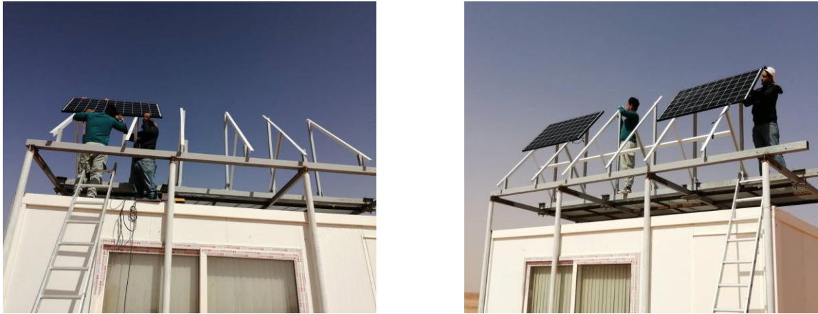
Figure 2.12 Installation des Panneaux Solaires
