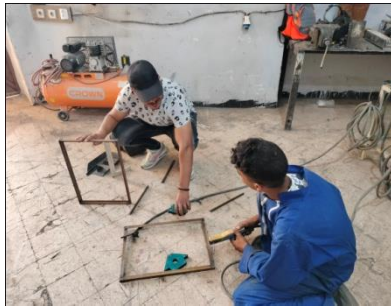
Assemblage de la structure
