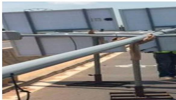
Figure (III.14) : Fixer le panneau
