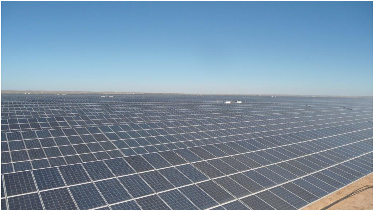
Figure (I.6) : Centrale Pilote Photovoltaïque d'Oued N'Chou 1,1 MWc
