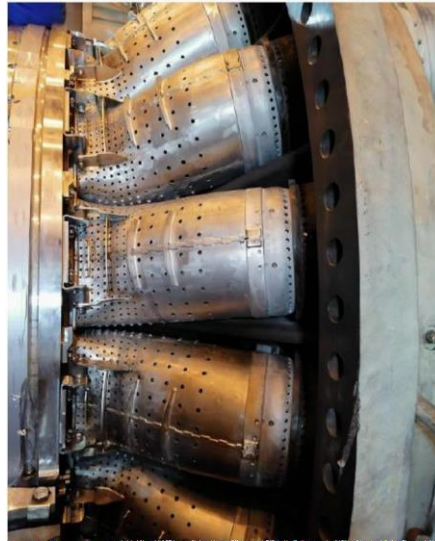
Figure II.5 : Disposition du système de combustion MS9001FA
