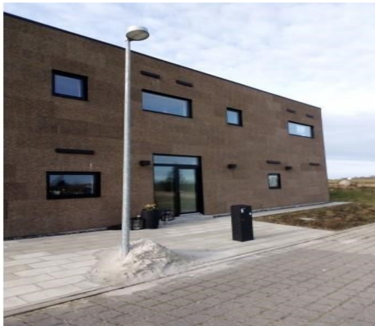
Figure 0-1 isolation extérieure avec le liège[30]
