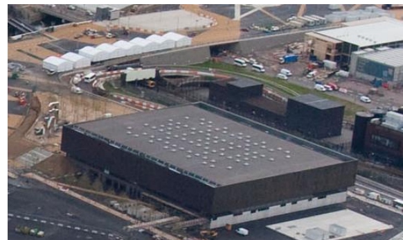
Figure 22 : le copper box Londres / Source * : Google image
