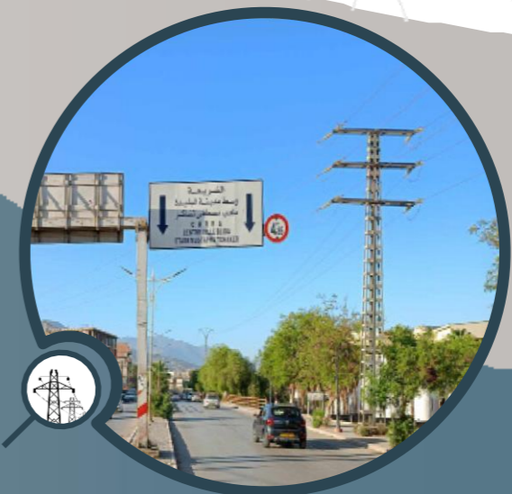
Poteau électrique Source : Auteur
