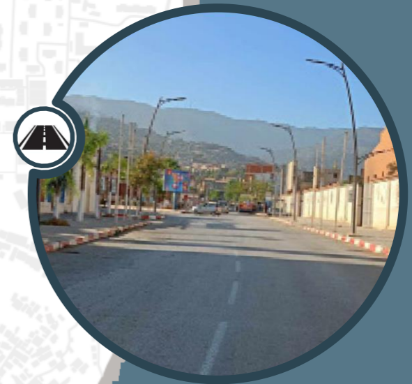
Voie W 143 Source : Auteur
