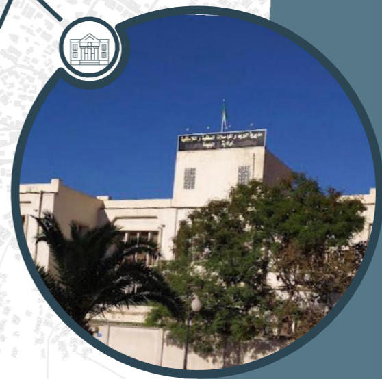
Direction des poste,télécommunication de blida Source : Auteur
