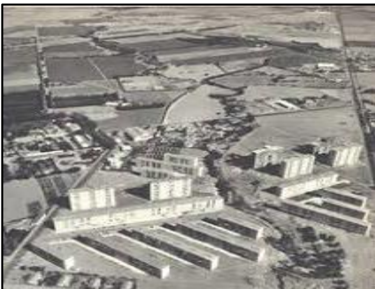
Figure: Vue aérienne de cité Montpensier
