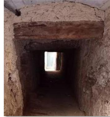
Figure 12 construction avec tronc de palmier a ksar Ouargla
